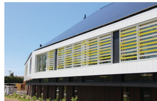
Le toit couvert à 95 % de panneaux solaires et les brise-soleil.
